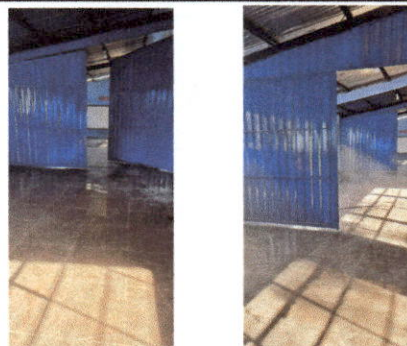
Foto 2: Entrepaños instalados y pisos cerámicos colocados en el módulo uno.
