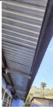
Foto 1: Techo de pestaña y canal de metal instalado por nuevas estructuras.
