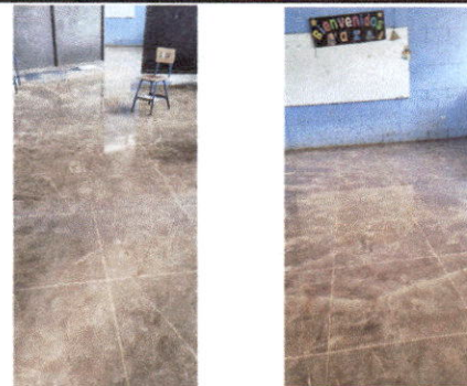
Foto 4: Piso cerámico instalados en las aulas de los módulos 2 y 4.
